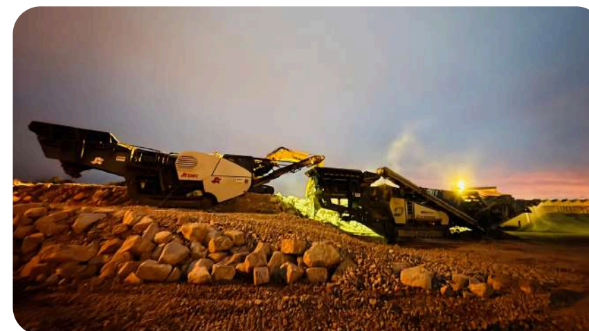
RCD A PIE DE OBRA
