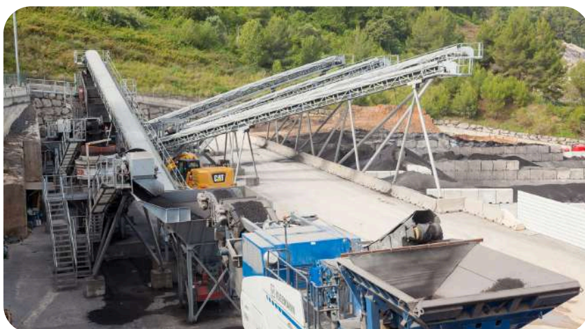
INSTALACIONES DE TRATAMIENTO DE RESIDUOS VALLIRANA
