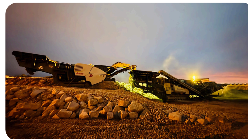
RCD A PIE DE OBRA
